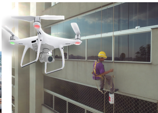
Inspeção presencial e drone
