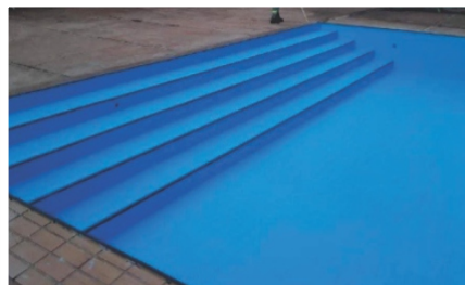
Impermeabilização com Everlast diretamente sobre o azulejo
