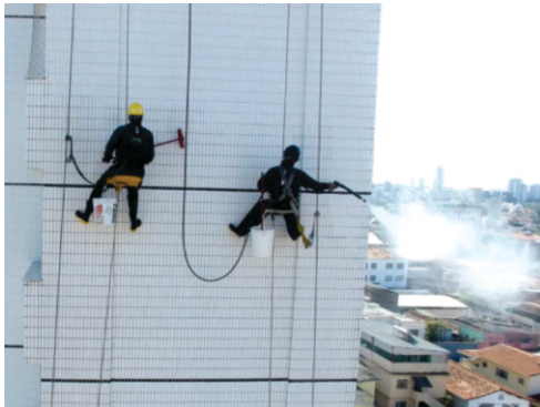
Limpeza e hidrofugação de fachadas
