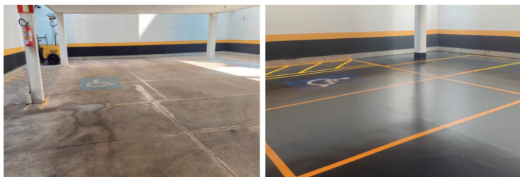
Garagem impermeabilizada com Everlast
