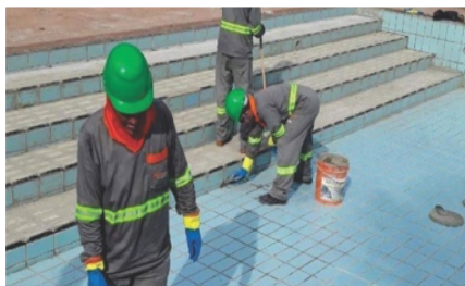
Impermeabilização com Everlast diretamente sobre o azulejo
